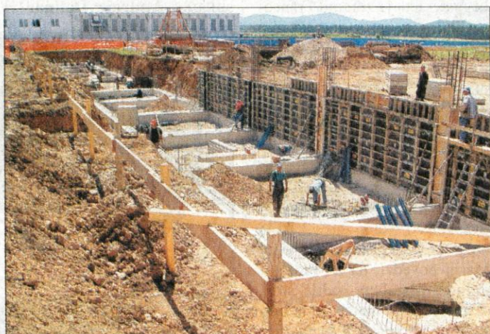
Temelji za brniški hangar.
