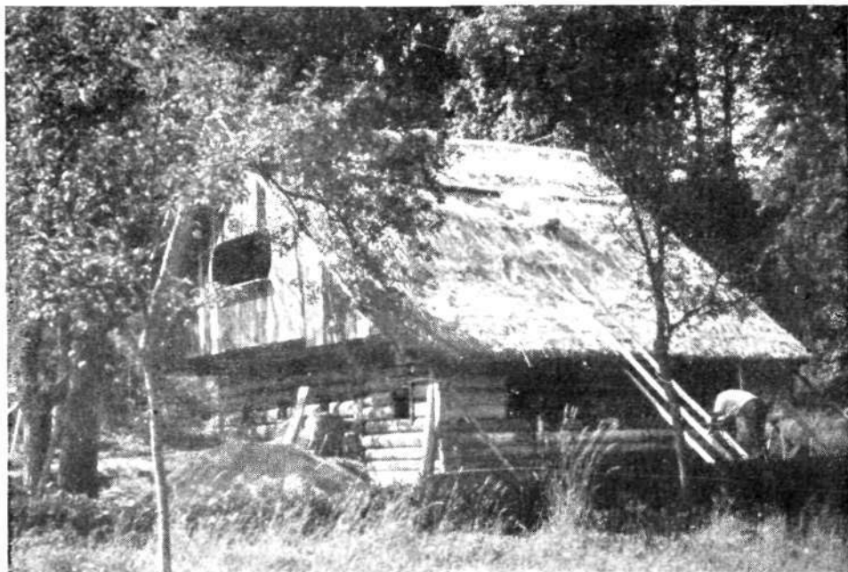
Na grajskem vrtu postavljena Skroparjeva hiša tik pred dograditvijo. (Foto Janez Eržen)
