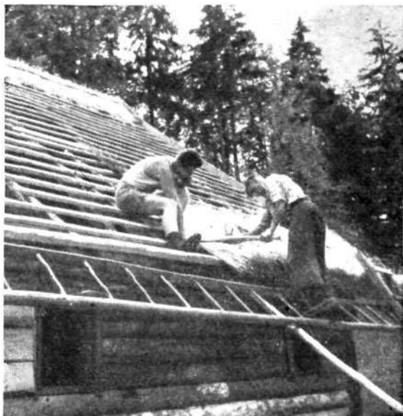
Strehar polaga kapno vez slamnate strehe na Škoparjevi hiši. (Foto Janez Eržen)
