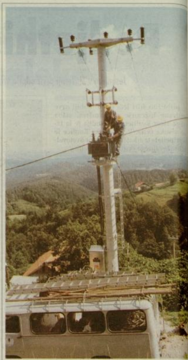
Monterja Elektra Celje Ivan Šuster in Zdenko Ramšak pripravi transformatorske postaje za priklop.
