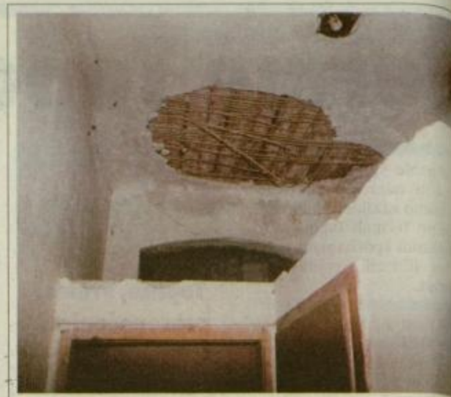
Strop nad skupnim straniščem.
