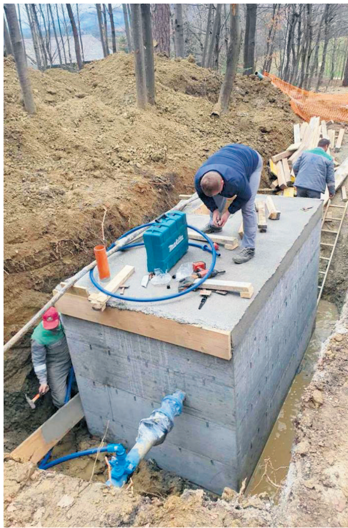
Novozgrajen vodovod je dolg približno 200 metrov. (Foto: Občina Slovenske Konjice)
