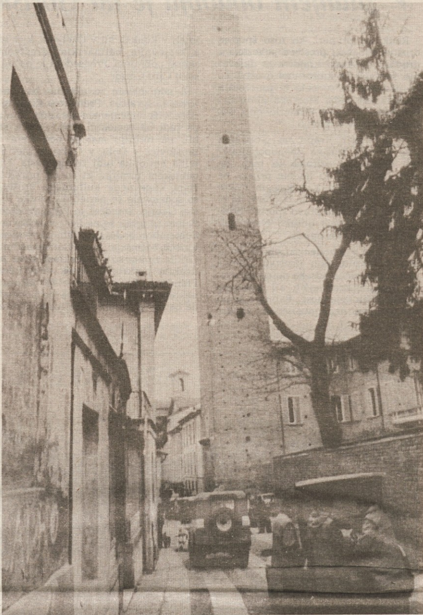
V Pavii so ugotovili, da nista stolpa Belcredi (na sliki) in Sv. Dalmazio povsem stabilna, zato so določili, da bodo s posebno pozornostjo sledili »premikom« obeh zgodovinskih zgradb (Telefoto AP)
