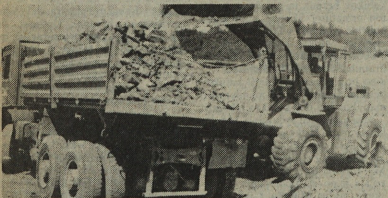
40 težkih strojev in tovornjakov dela na gradbišču dnevnega kopa v Kamengradu
