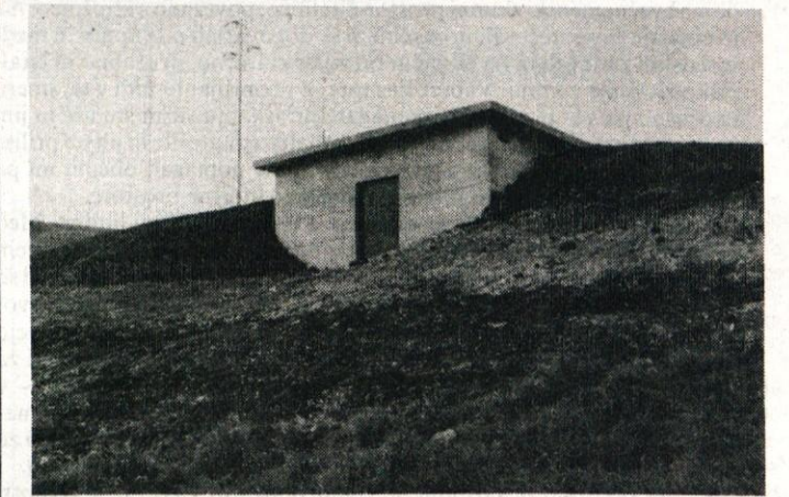
V novozgrajenem vodohramu na Storževem griču je prostora za 40 kubičkov vode, kar bo zadostovalo tudi ob večjih sušah.
