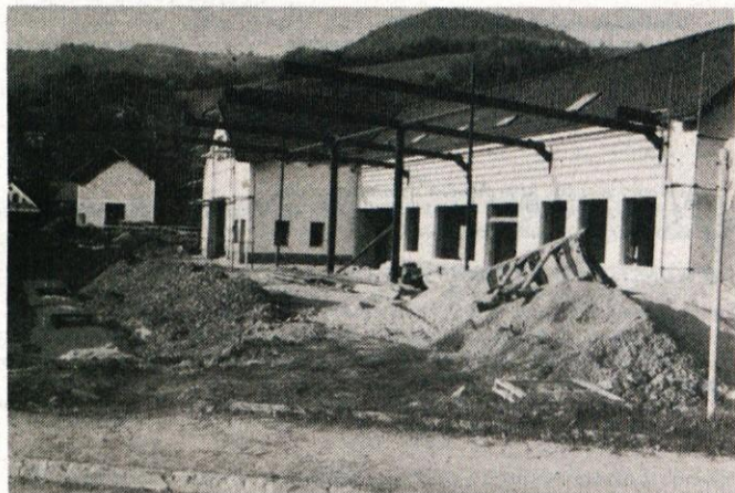
KMALU NOVA BENCINSKA ČRPALKA — V Horjulu pospešeno gradijo novo bencinsko črpalko, kot pravi graditelj Franc Lončar, bo morda nared do konca tega leta. Te dni so namreč že vkopali cisterne za gorivo, dokončali fasado in že montirajo montažne nosilce za streho novega bencinskega servisa. (F. B.)
