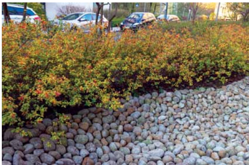
Slika 6: Suhe struge imajo drenažno podlago in ponikajo padavinsko vodo.
