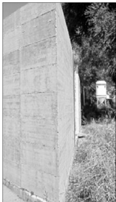
Gradbišče v Romjanu
