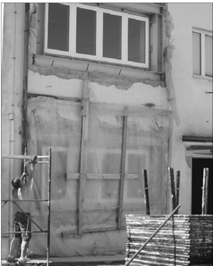
Nameščanje gradbenega odra
