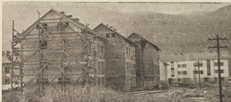
V ospredju trije petorčki KGP v gradnji, v ozadju pa dva od treh, ki so že vseljeni
