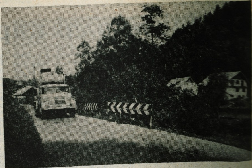
Na cesti od Kamne gorice do Kropa že nekaj mesecev zre nevarna usedlina. Je cestišče pred časom izpodjedla narasla Lipnica. Vendar se nihče ne zanaša, da bi cesto, ki je posebej za šolarje in delavske avtobuse nevarna, popravili. Zadnje čase brze po njej tudi težki tovornjaki, ki iz kamnoloma vozijo kamenje.
