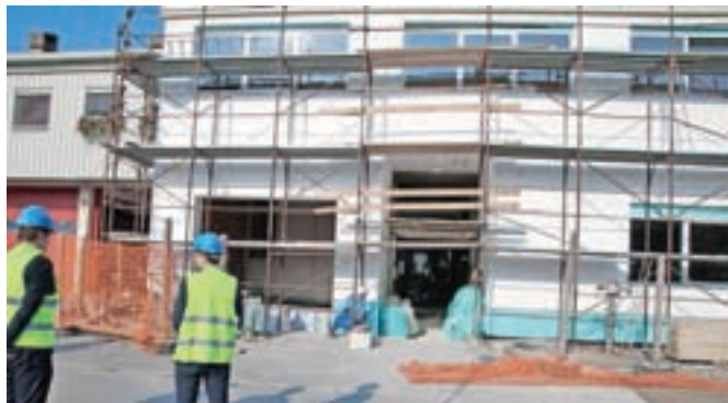
Gradnja prizidka za štabno sobo / FOTO: OBČINA KAMNIK
