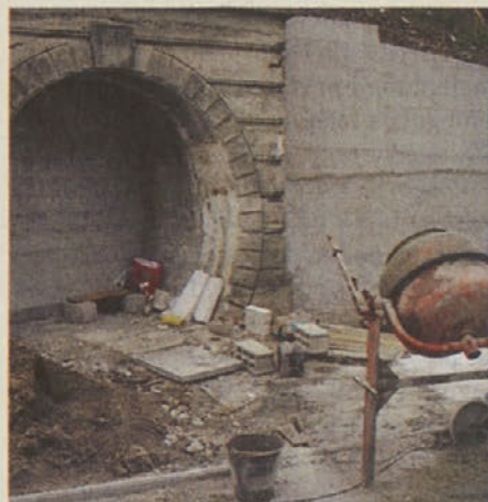
Obnovitvena dela zajemajo tudi nekdanje rudniške vhode, ki bodo poslej kulturni spomeniki Občine Zagorje. (Foto: Vukašin Šobot)
