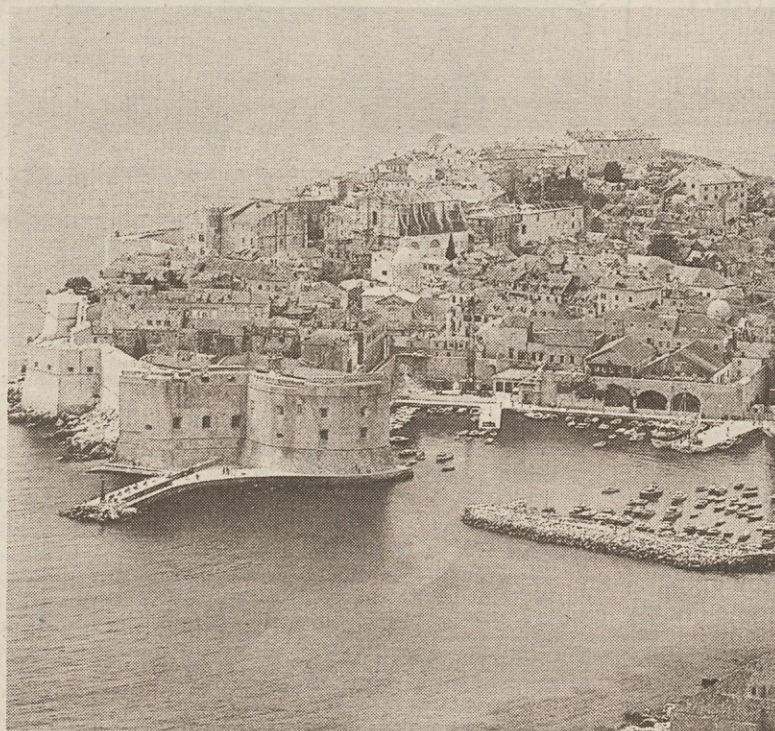
Pogled na Dubrovnik - »Trulli« - tipične stavbe v Apuliji
