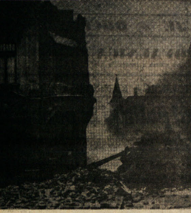
Nejaki sekund potem, ko se je v Ulici Maršala Tita zrušil na cesto del stanovanjskega poslopja
