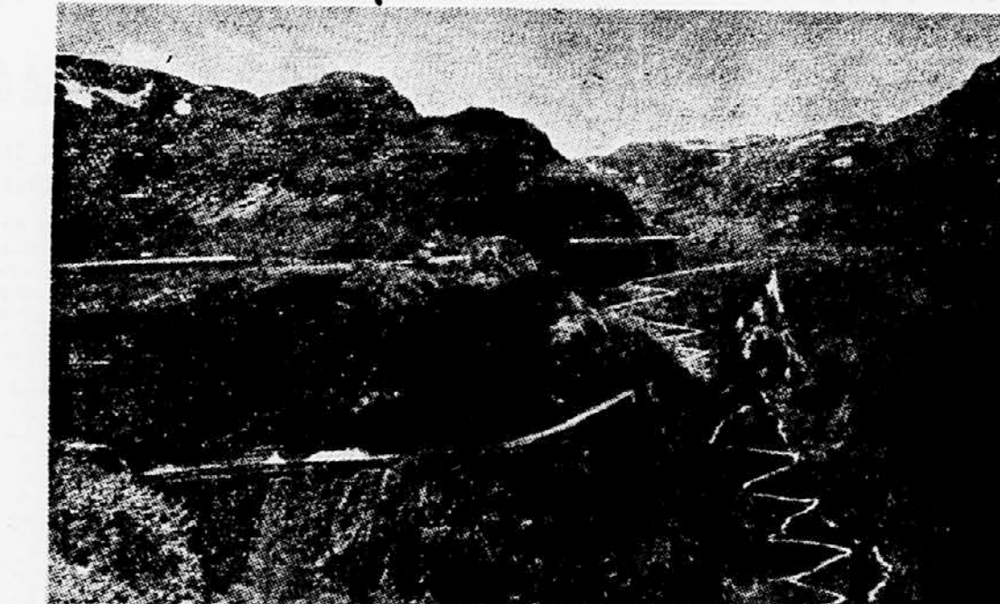
Strma železniška proga se iz gorske postaje Myrdal v bergenskih hribovih spušča v 56 minutah skozi 20 predorov od višine 1000 m do morske gladine v Flamju.
