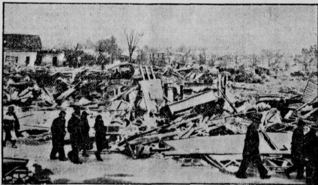
Strašne posledice tornada. V Ameriki je nedavno divjal strašen tornado, porušil številna naselja in 300 ljudi je postalo žrtev tega nasilnega viharja. Najbolj je trpelo mesto Northport v Alambi. To cvetoče mesto je skoraj popolnoma razrušeno, kakor nam kaže slika.
