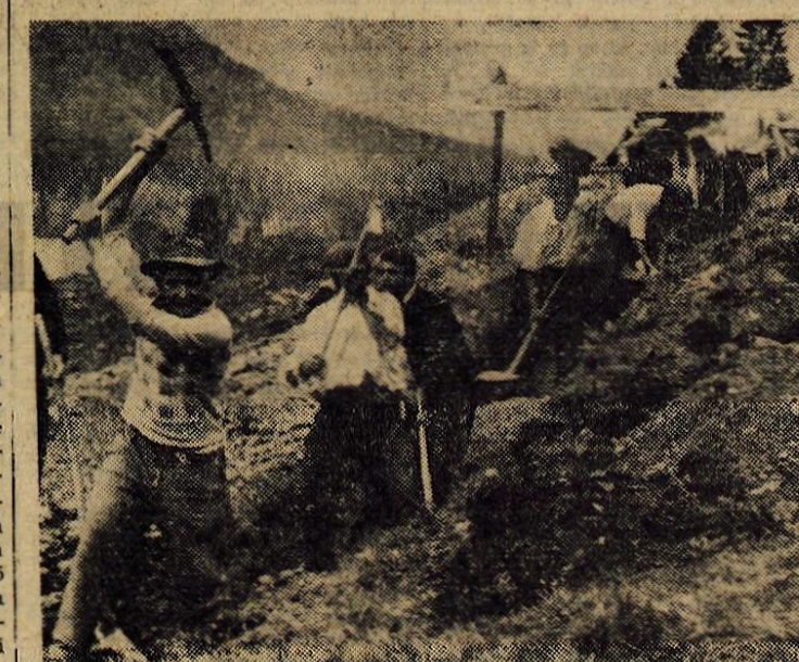
Na Jesenicah je bilo slišati zadnja leta mnogo kritike zaradi slabega vodovoda. Delavci komunalnega podjetja pa kopljejo nad Hrušico globok jarek za nov vodovod, ki bo speljan do Jesenic in naprej do Zirovnice. S tem bo rešen eden izmed mnogih problemov, ki tarčajo prebivalce Jesenic
