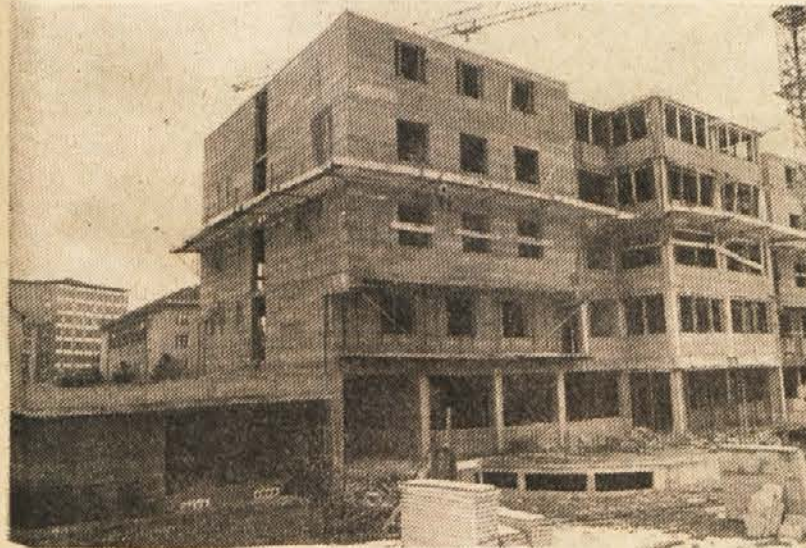
SŠD začelo graditi nov dijaški dom v Celovcu
