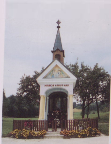
Obnovljena kapela v Grabšincih
