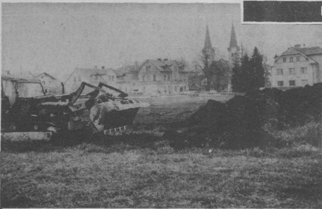
Dela za vodovod do središča Polja so v teku. Kaže, pa, da bo nekaj težav pri odseku skozi naselje, saj trasa novega vodovoda ne teče tako, kot je bilo dogovorjeno. Na sliki: Takole so nedavno tega začeli odstranjevati zgornje plasti zemlje za vodovodne cevi premera 30 cm. (Foto: Dušan Jež)
