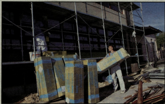
Sanacija OŠ Polzela
