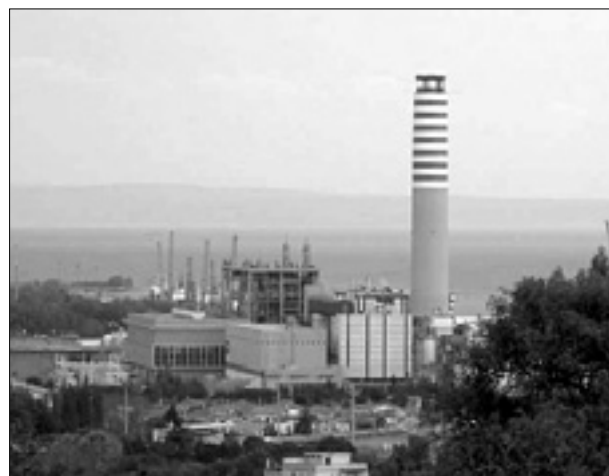
Termoelektrarna v Tržiču
