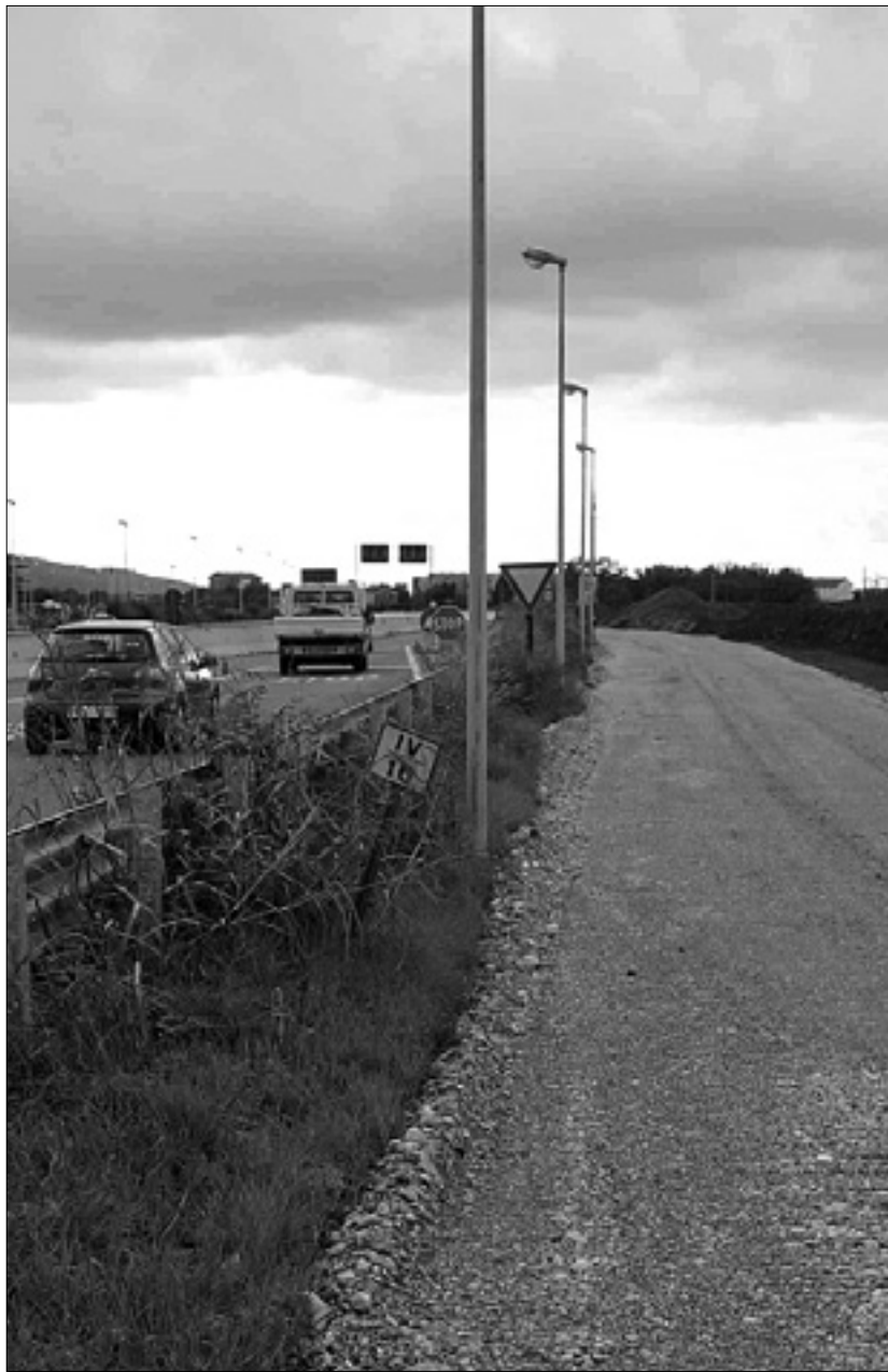
Gradbišče nove avtoceste pri Štandrežu
