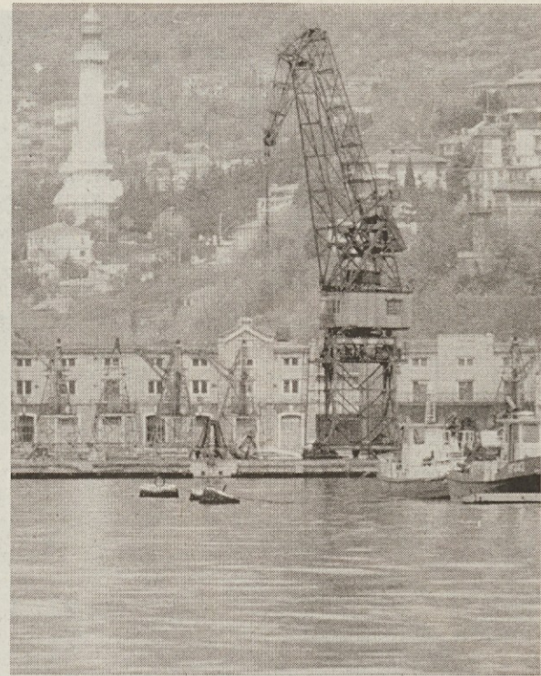
Pogled na trzasko pristanišče (foto Krizmančič)
