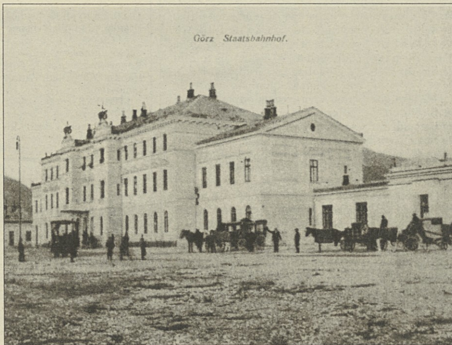
Povezavo severne postaje e centrom mesta so nekoč zagotavljale kočije
