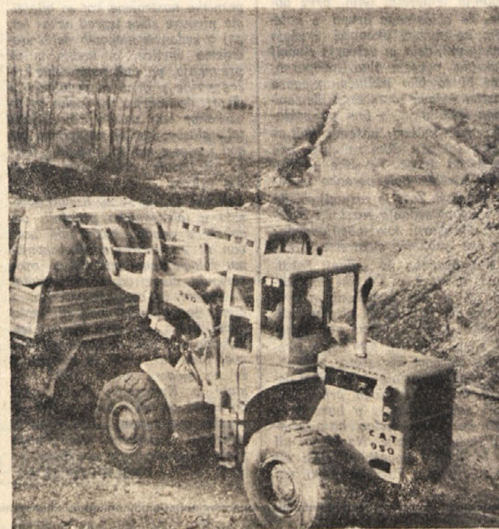
Z buldožerjem kopljejo jarek bodoče avtocestne trase in nalagajo material na tovornjak; v ozadju trasa avtoceste proti Soči
