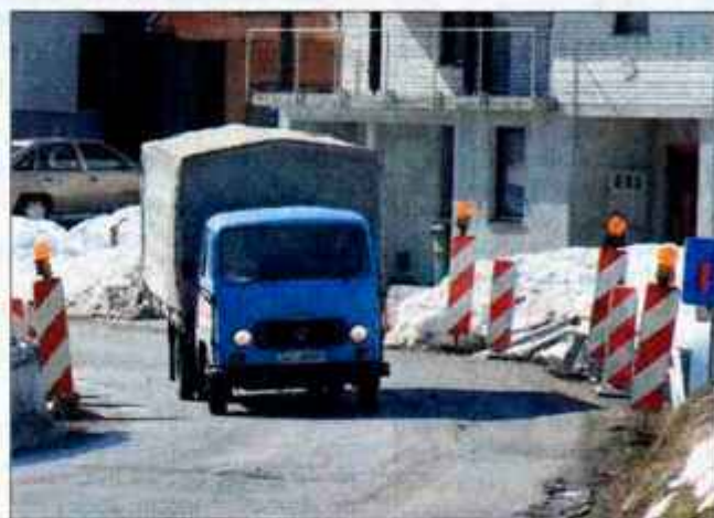
Obnova regionalne ceste Hotavlje - Trebija se bo končno začela. Takšnih prizorov čez dve leti ne bo več.
