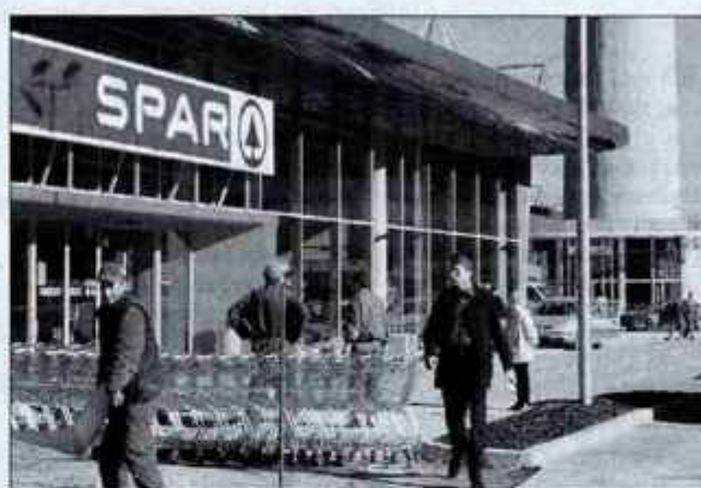
V sredo popoldne so na nakupovalnem centru pred četrtkovim odprtjem opravljali še zadnja dela.
