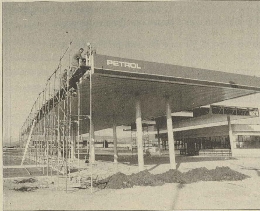
Delavci Primorja hitijo z gradnjo servisa na MMP Vrtojba (Foto: O'Hara)
