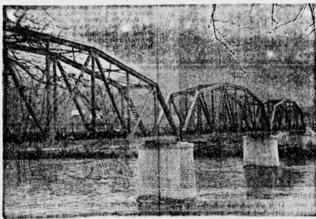
Novi železniški most čez Savo pri Sevnici.
