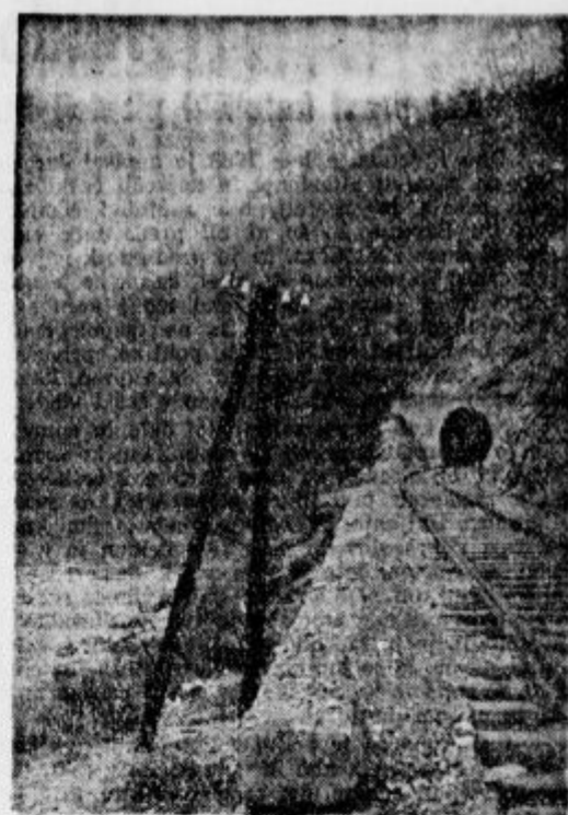
Tunel na progi.
