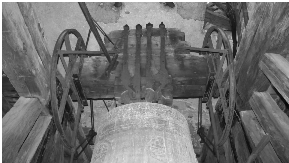
Slika 8: Zgornje polje Codellijevega zvona s podobama, okrasjem, napisi, krono, jarmom in obesilnimi vezmi (foto: Matjaž Ambrožič)
