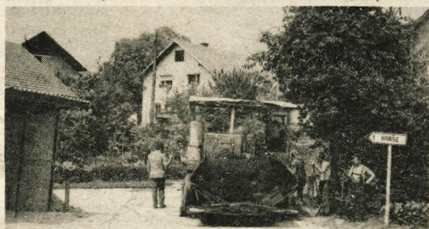
Asfalt na belskih cestah. Na sliki delavci in stroji Slovenijacest iz Ljubljane pri polaganju »asfaltnege tepih« na Spodnji Beli - Foto: C. Z.
