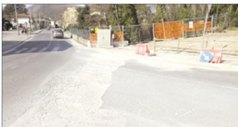
Neasfaltirano cestišče pri pevmskem mostu FOTO VIP
