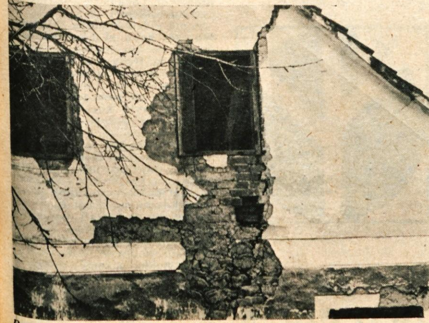
Potresni sunki so krepko razmajali hišo Joška Hrovata iz Serovega nad Šmarjem. Obodne stene so se nagnile in pojavile so se grozeče razpoke.
