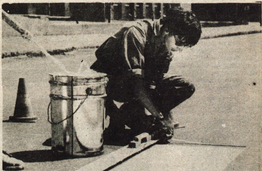
Kranj — Pred turistično sezono je treba obnoviti talno cestno signalizacijo. Delavci cestnega podjetja te dni lepšajo ceste po Kranju. Na sliki je Matjaž Juvan s sodelavci na delu pred Globusom. Foto: G. Šinik.
