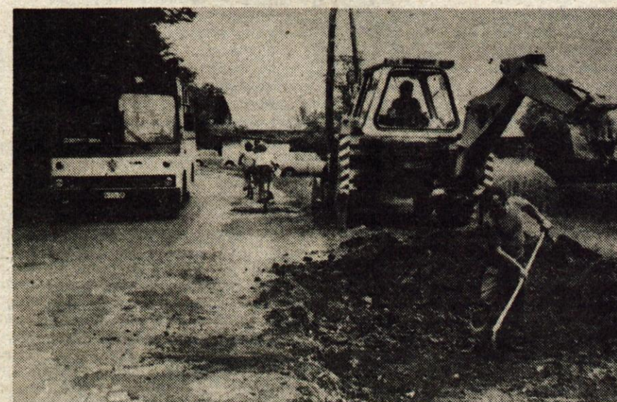
Cesta Hrastje—Prebačevo — V začetku tedna je Cestno podjetje iz Kranja začelo z deli na enem najbolj kritičnih odsekov ceste Čirče—Trboje v Prebačevem. Po programu bodo dela trajala do 12. julija, do takrat pa bo trajala tudi zapora prometa na cesti Čirče—Prebačevo. — A. Ž. — Foto: F. Perdan
