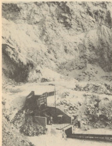
Še pogled na zasneženi kamnolom Paka v smeri dosedanjega edinega sekundarnega drobilca v njem
