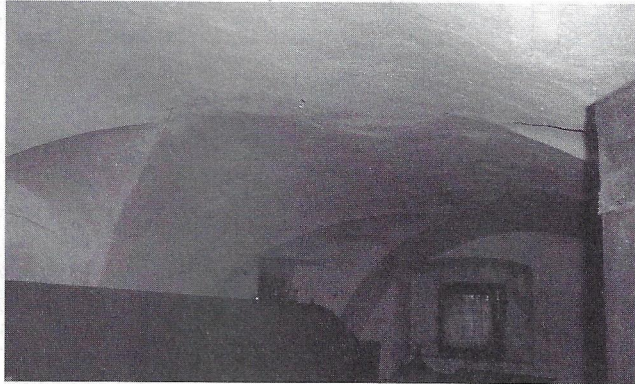
Notranji detajl gradnje hiše z imenom Lahovče (masivni oboki izrazito izdajajo baročni način gradnje te domačije)
