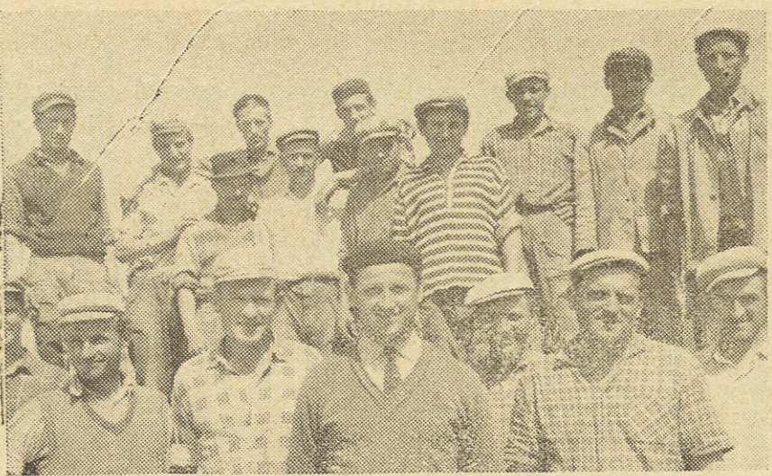
Daleč na Dravskem polju gradi mariborski kolektiv veliko tovarno za močna krmila. Tu vam predstavljamo del graditeljev
