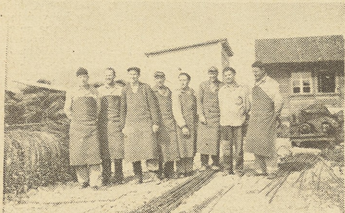
Železokrivska skupina tov. Hajdiniaka (tretji od leve proti desni), ki bo imela letos na gradbišču Koper zopet polne roke dela
