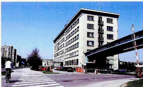
Stavba LPP na Celovski cesti
