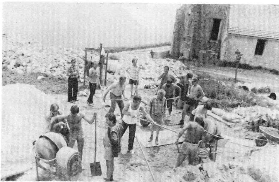
Betoniranje plošče 22. 7. 1981 na Uršlji gori
