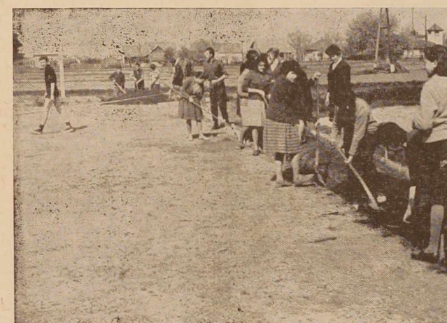
Dijaki Srednje šole za telesno vzgojo v M. Soboti so si uredili športno igrišče. Slika kaže dijake pri delu.
