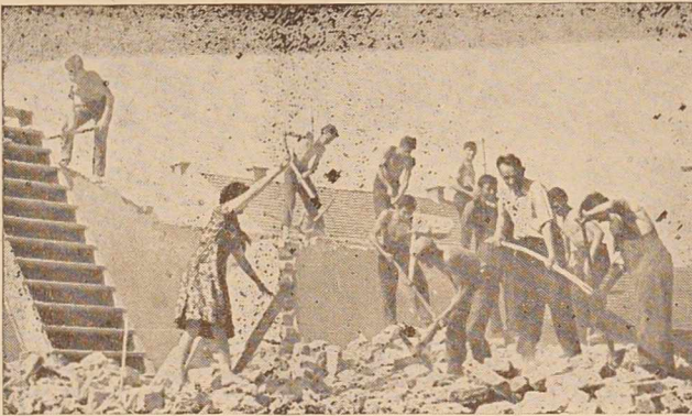
Učenci šole raznih strok v M. Soboti pri rušenju zgradbe na St. Kovačevi ulici
