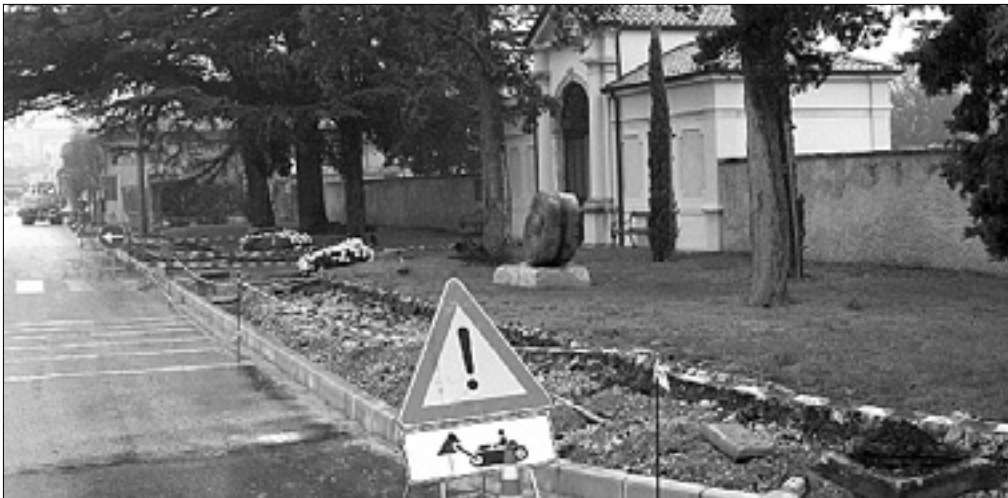
Gradbišče pred pokopališčem
