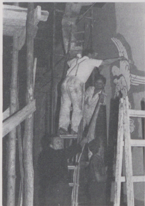
Obnavljanje župnijske cerkve v Kuzmi
