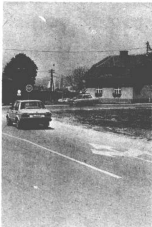
Dolgo je stara hiša na križišču Tomšičeve in Koroške v Titovem Velenju kljubovala času. Sedaj so jo podrli in upamo, da bo križišče kmalu takšno, kot mora biti.
