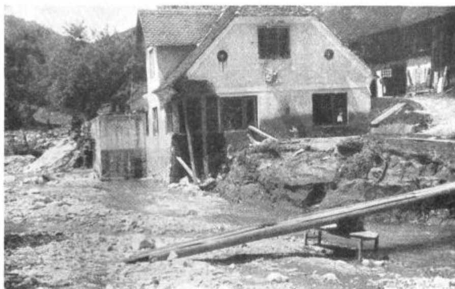
Slika 6. Deroča voda v času poplav uničuje sadove človekovega dela. V času junijske poplave 1954. leta je Pirešica poškodovala mnoge zgradbe mlinov in in ob vodi stojećih hiš
