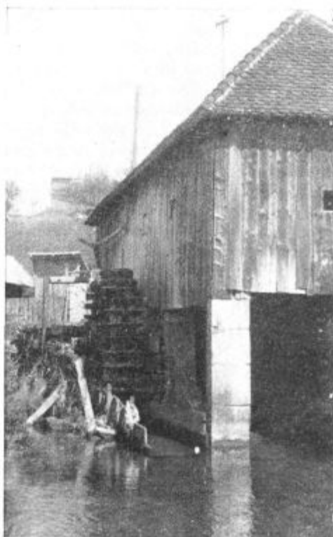
Slika 7. Tudi žage so mnogo prispevale k spremembam domov v Spodnji Savinjski dolini. Večino od njih so poganjala vodna kolesa »na lopate«
