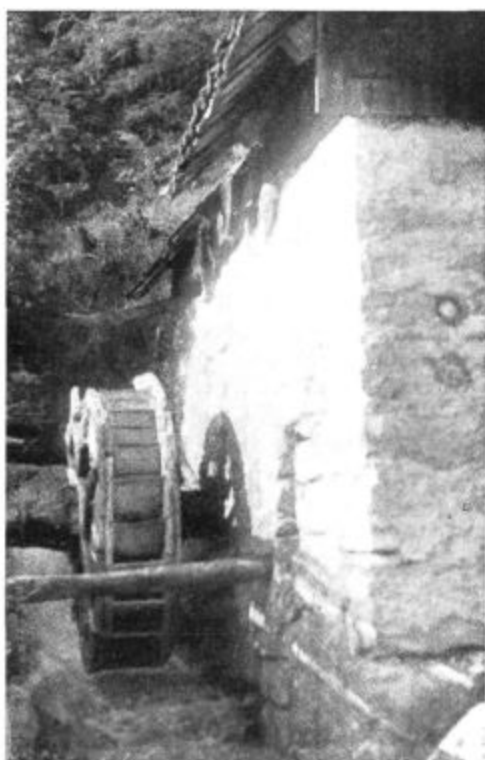
Slika 5. Zaradi majhne množine vode so v hribovskem svetu mlinška kolesa »na korce«
