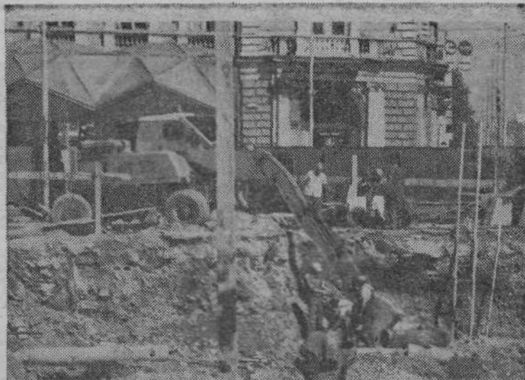
Prestavitev primarnega vodovoda ni bila lahka stvar. Tako je človeški sili priskočil na pomoč tudi stroj.
