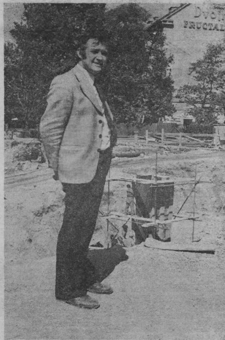
Naš sogovornik, inž. Vili Štrukelj, pod njim eden od stebrov v gradnji.
