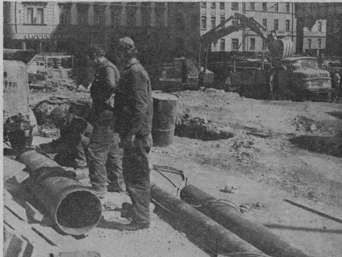
Delavci pri prenosu primarnega vodovoda, ki so povzročili del zamude. V ozadju izkop jame za podhod (pred Metalko).
