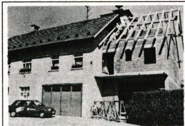
Prizidek k gasilskemu domu v Naklem bo kmalu pod streho.
