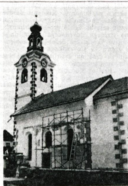
Glavna dela na fasadi so končana.
