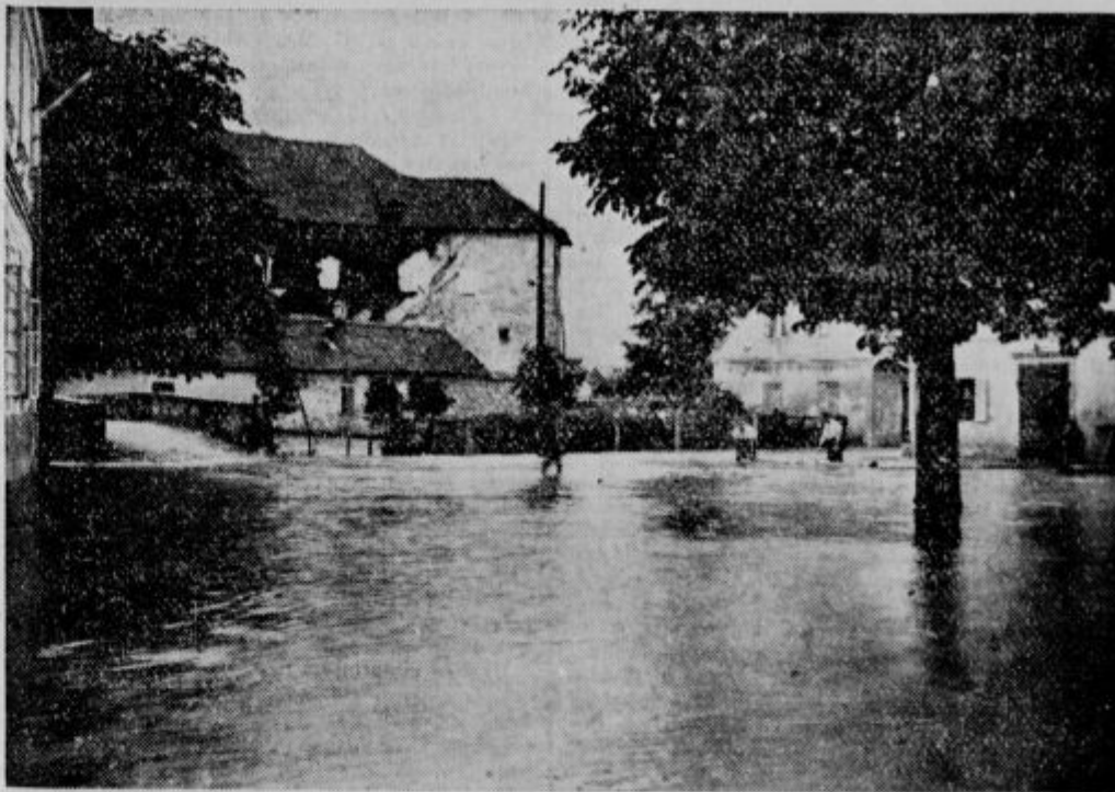
Povodenj v Ribnici: Reševalna dela ob zidanem mostu.
