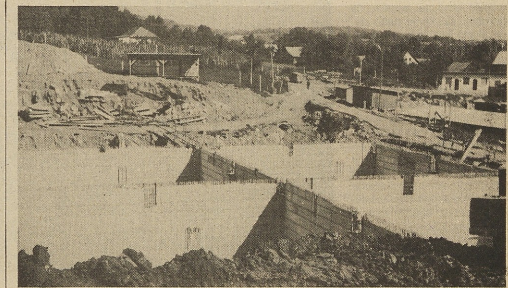
Vodotesni betonski bazen, ki je sestavljen iz štirih celic. Vanj so vgradili 4.700 m 3 kondenzatorskih odpadkov in onesnažene zemlje.
