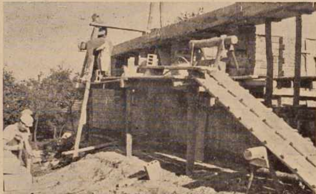
Na sliki: Gradnja kopalnice in pralnice na Murščaku
